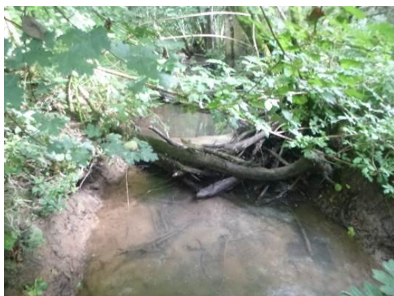
Embâcle problématique dans le lit du cours d'eau
